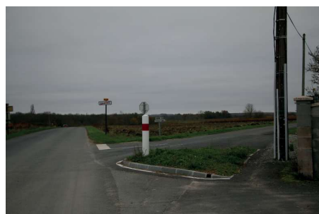
Aménagement du carrefour Route de Bourras & Route de Cheville
