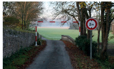
Portique installé sur le pont N°1
