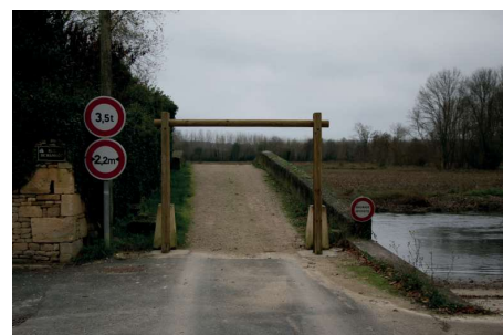
Installation d'un portique sur le pont de Bassigeau
