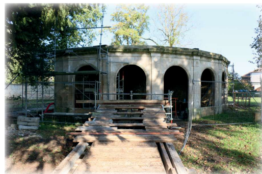
Photo prise pendant les travaux
