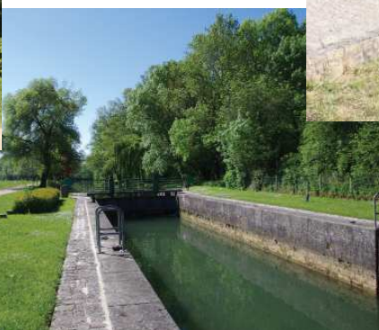
Ecluse de Saintonge - Aire de repos
