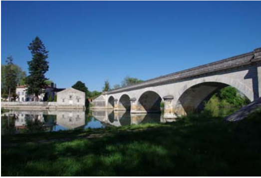
Pont de Vinade
